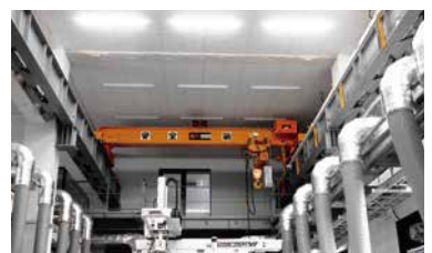
6tクレーン
