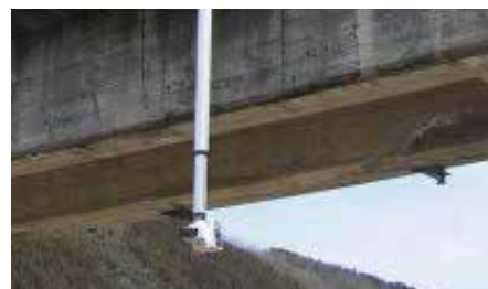
ロボットカメラを用いた橋梁点検
