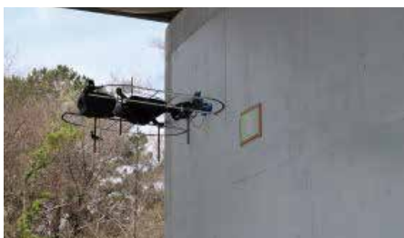
点検ロボットを用いた橋梁点検
