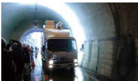
高速走行車両を用いたトンネル点検
