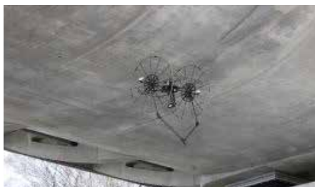
点検ロボットを用いた橋梁点検
