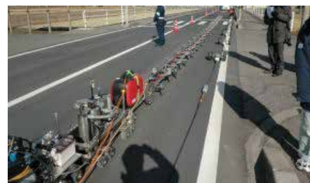
舗装と盛土構造の点検
