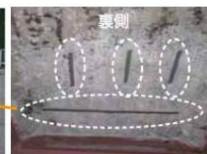
未補修のひび割れの経過観察
