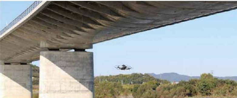
各務原大橋とドローン
