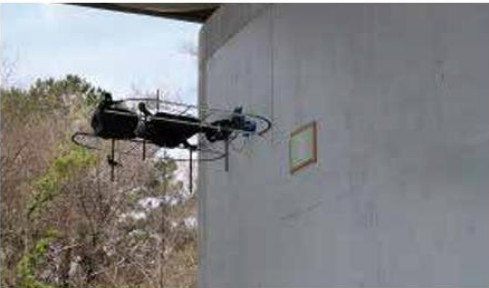
点検ロボットを用いた橋梁点検
