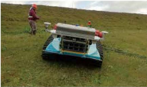
河川堤防の点検
