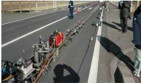
舗装と盛土構造の点検
