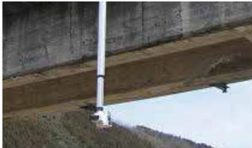
ロボットカメラを用いた橋梁点検
