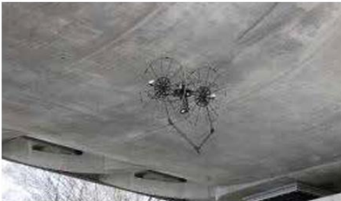
点検ロボットを用いた橋梁点検
